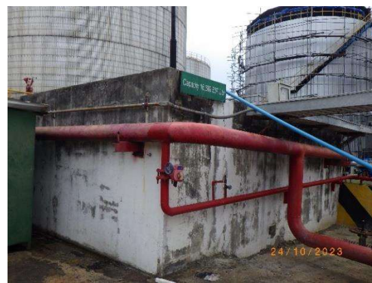
รูปที่ 2-19 กำแพงกันล้อมรอบถังเก็บแอสฟัลท์
