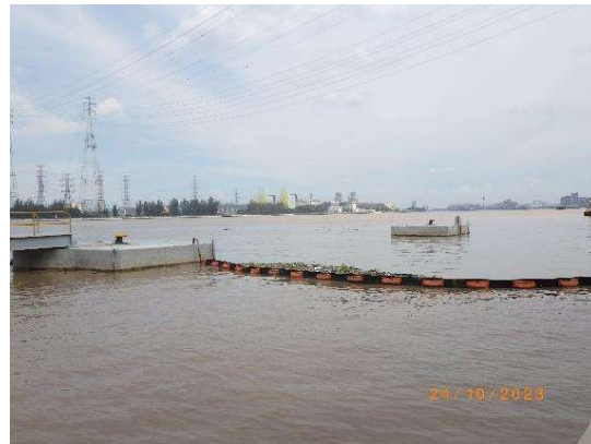
รูปที่ 2-6 การใช้อุปกรณ์ท่อนักน้ำมัน (Boom) เพื่อป้องกันการแพร่กระจาย
