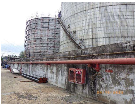
รูปที่ 2-19 กำแพงกันล้อมรอบถังเก็บแอสฟัลท์
