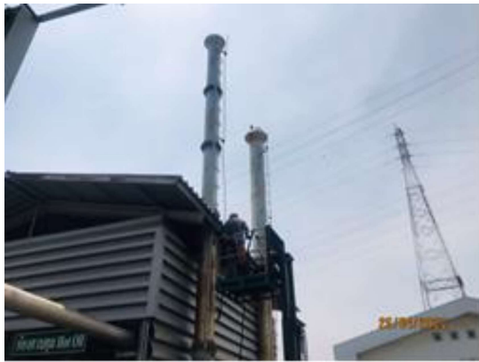
รูปที่ 2-1 การติดตามตรวจสอบ คุณภาพอากาศจากปล่อง Hot Oil Boiler
